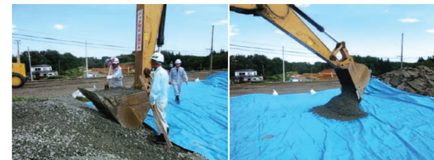
① 20～0mmをバケツで計量（2杯）
