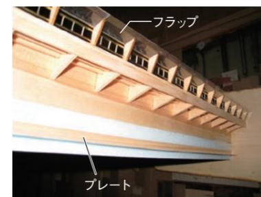
写真1 耐風対策構造細部拡大
