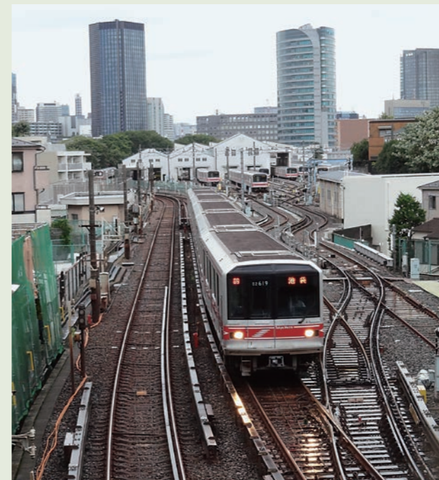
写真4 茗荷谷の車両基地
