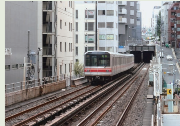
写真2 後楽園駅から地上部とトンネル坑口を望む
