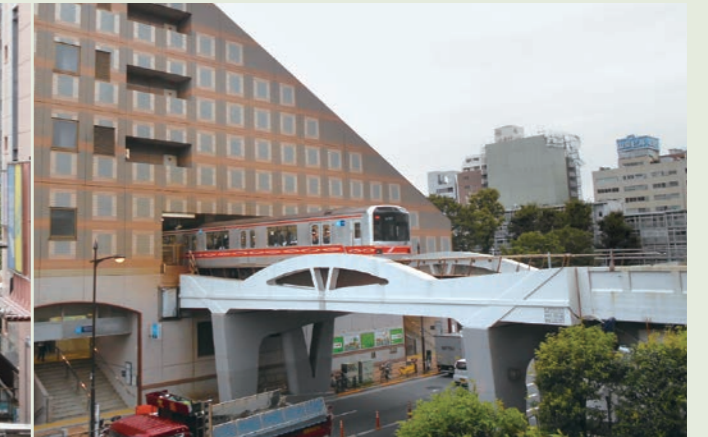
写真3 橋梁を渡り後楽園駅ビルへ入る丸ノ内線
