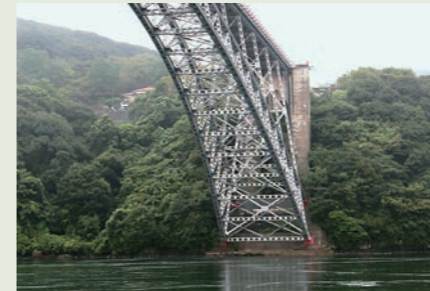
写真5 南側橋台とアーチ基部
