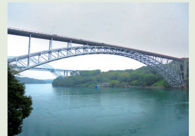
写真8 伊ノ浦瀬戸と西海橋
