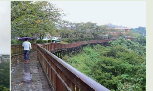
写真7 西海橋と新西海橋をつなぐウォークデッキ
