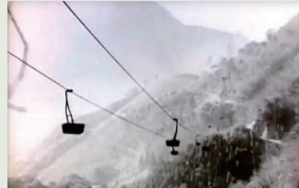
写真4 索道による資材の運搬
