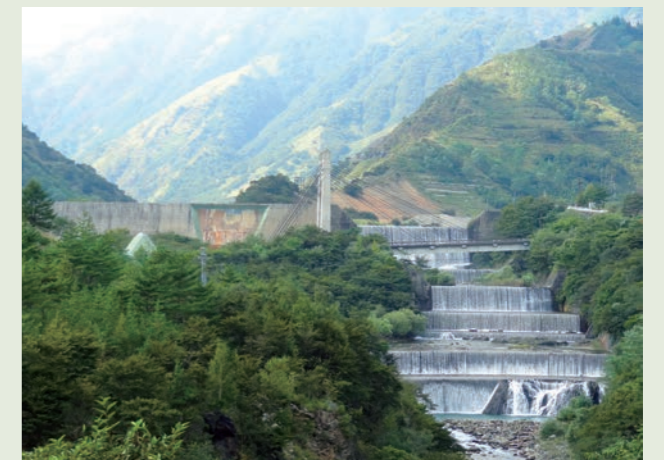
写真8 足尾砂防堰堤の全景
