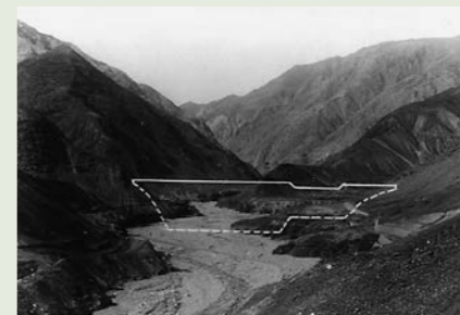
写真3 足尾砂防堰堤の工事前
