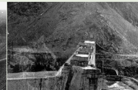
写真4 工事中の足尾砂防堰堤
