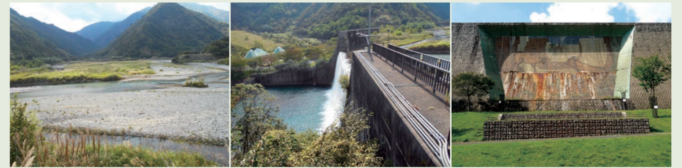
写真5 三川が合流する足尾砂防堰堤上流部
