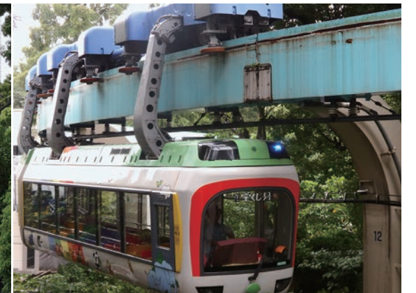
写真6 軌道桁とモノレール
