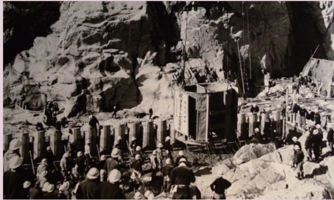
写真3 コンクリート打設
