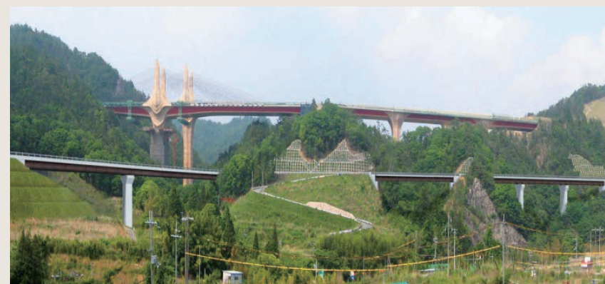
大津信楽線34号橋 コスト削減と工期短縮に考慮した鋼単純非合成箱桁橋
