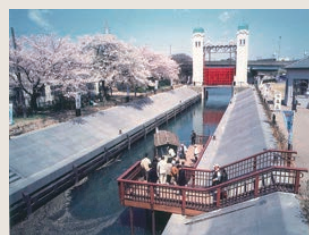
宇治川 三栖閘門 治水機能維持と歴史文化の継承に配慮した周辺整備計画
