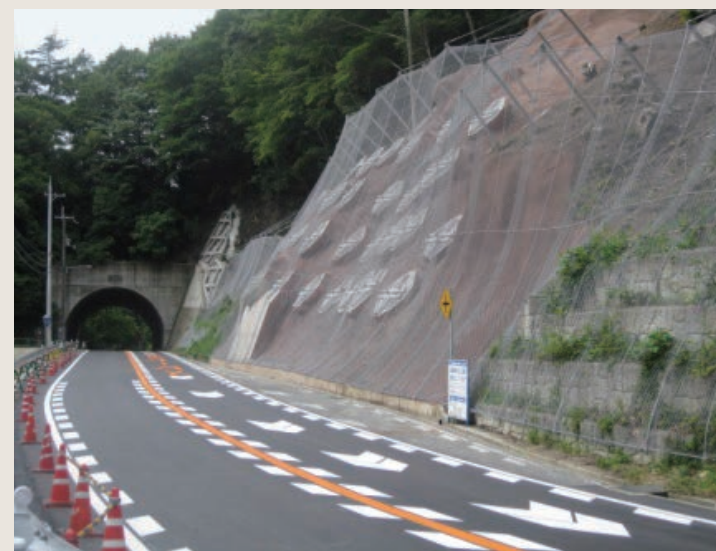
国道168号（道路防災対策） 災害危険箇所の落石防護網工とグラウンドアンカー工の設計
