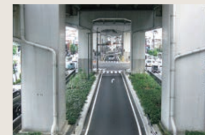
国道43号（渋滞対策） 渋滞緩和対策としての高架下右折レーンの増設設計
