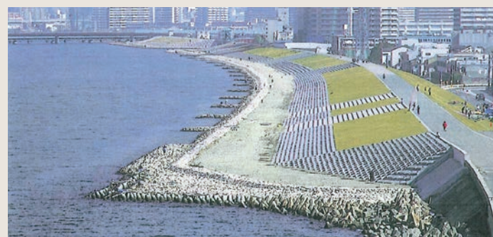
淀川 西島みらい堤 環境に配慮した緩傾斜堤防の設計
