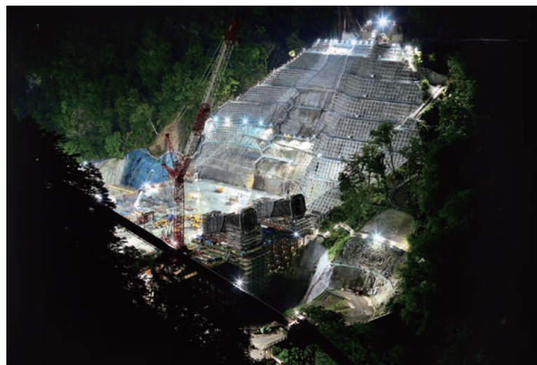
「ハッ場ダム昼夜施工決行中」 東京都 櫻井 幸夫 (撮影地：群馬県吾妻郡長野原町)
