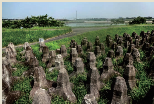
「水防用テトラポット」 熊本県立八代工業高等学校 本田 悠智 (撮影地: 熊本県八代市)
