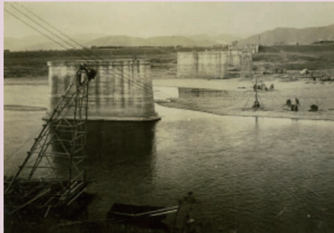
写真2 施工中の橋脚
