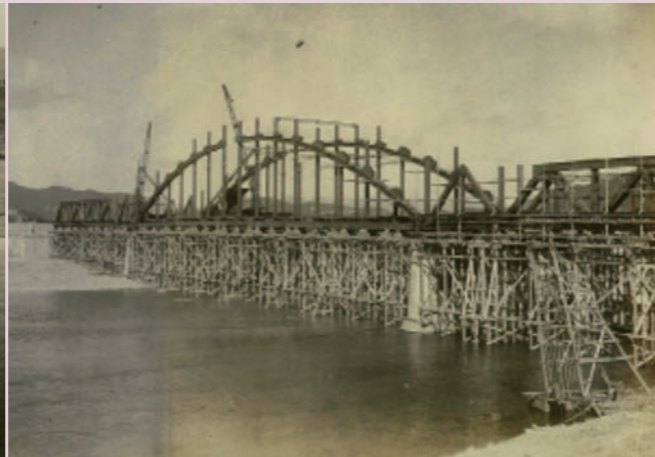
写真3 施工中の中央径間部
