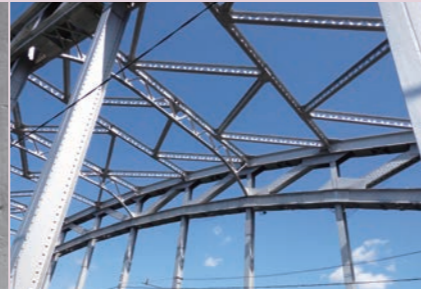
写真5 ブレースドリブアーチのトラス部
