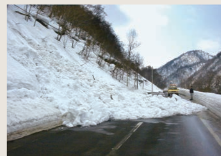
雪崩が発生した道路の緊急調査
