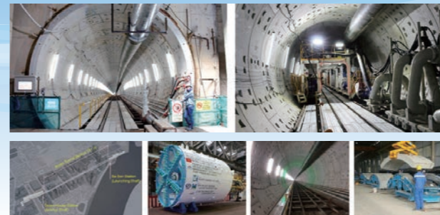
写真1 ホーチミン都市鉄道プロジェクトのシールド工事
