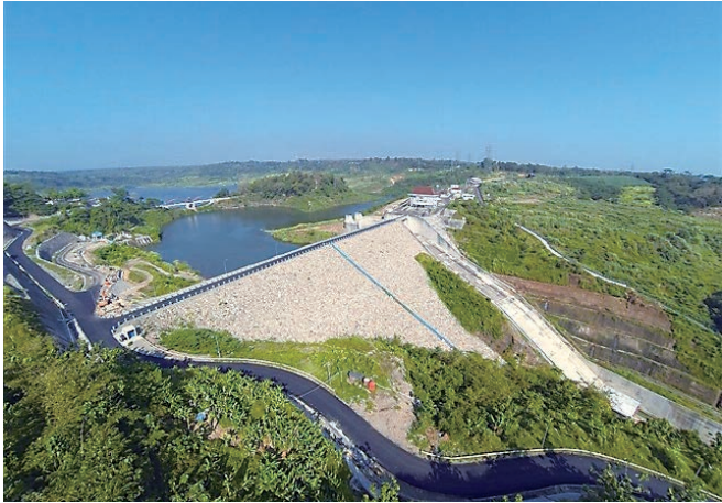
写真3 日本の協力によるインドネシア・スマラン地域総合水資源管理プロジェクト
