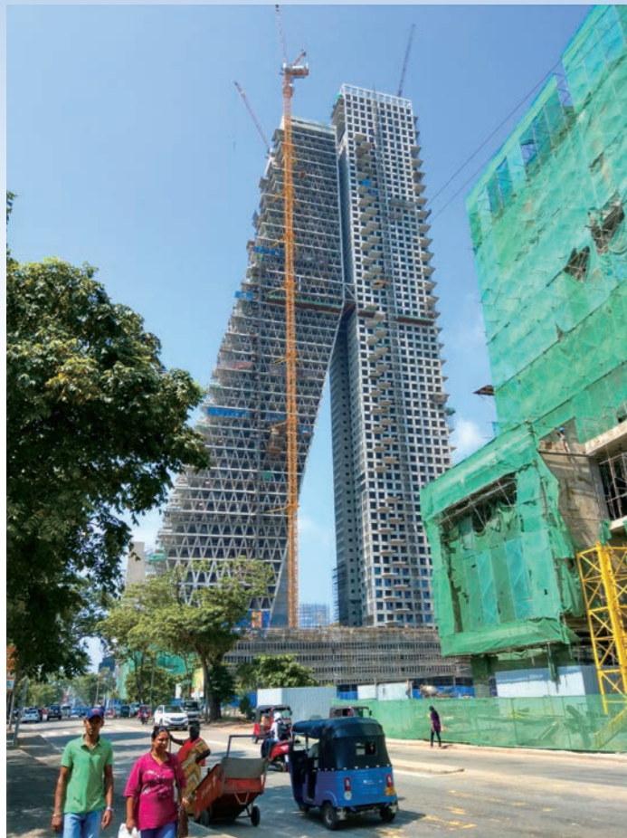
写真6 コロンボ中心部で建設中の超高層ビル
