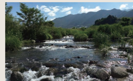
巨石を組み合わせた工法による重川の多自然川づくり
