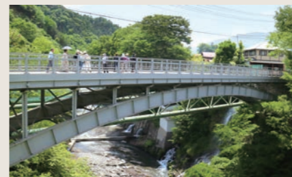
近代土木遺産の橋梁補修・補強設計
