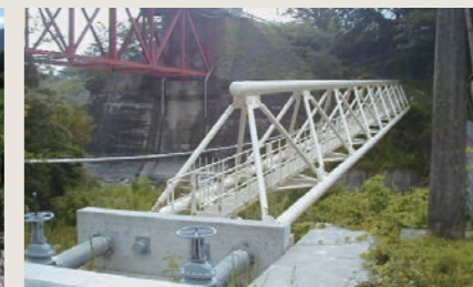
日川を跨ぐ丸林水管理橋
