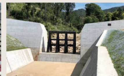
流木の捕捉に有効な透過型砂防堰堤
