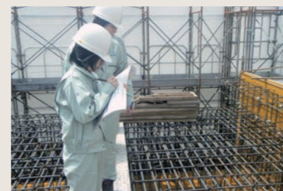
現地施工調査②
