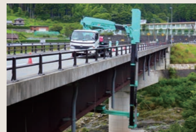
【業務事例】橋梁点検
