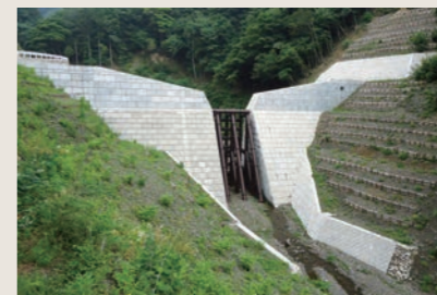
【業務事例】砂防堰堤
