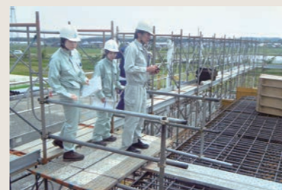
現地施工調査①
