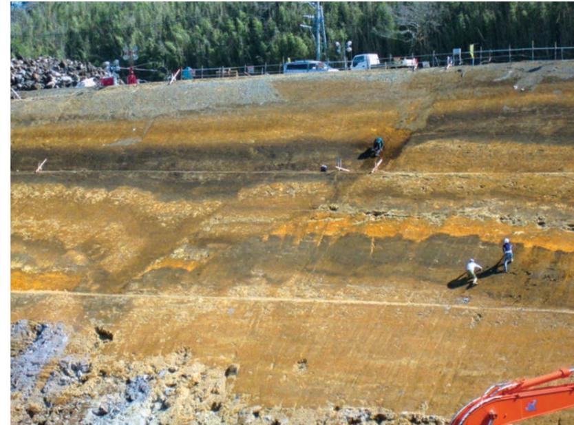
写真4 立野火口瀬の工事現場で見られた断層
