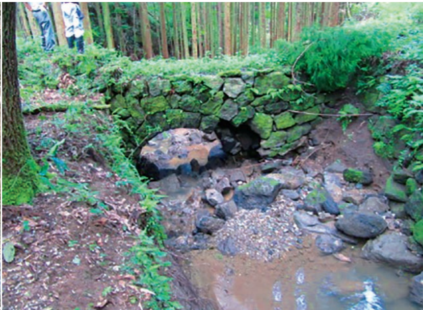
写真5 熊本地震により半壊した二俣福良渡の解体復元工事
