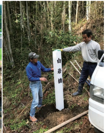
写真8 標柱の設置作業
