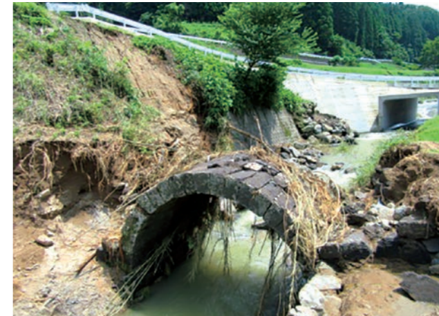
写真7 2016年6月の洪水で輪石だけが残った下用橋(熊本県美里町)
