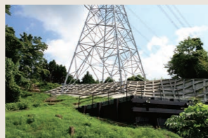
災害対策 地盤補強工の設計
