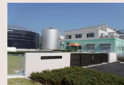
みやま市バイオマスセンター 導入支援（生ごみ等バイオガスセンター発電施設）
