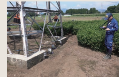
鋼材基礎劣化診断
