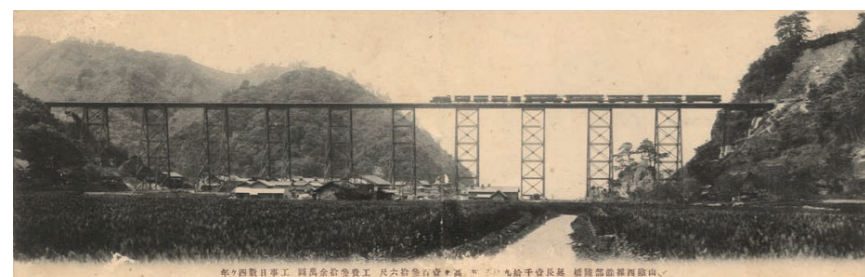
写真1 建設当時の余部鉄橋(写真:土木学会附属土木図書館デジタルアーカイブス)
