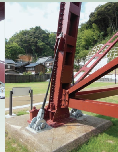
写真4 当て板補強とPCケーブルによる耐震対策
