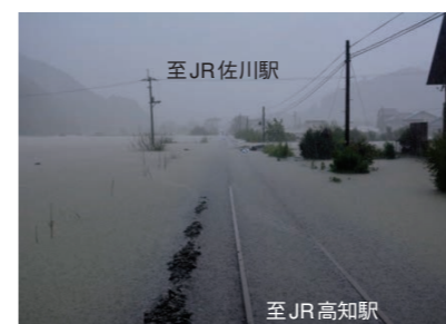
図5 JR土讃線軌道敷の浸水状況
