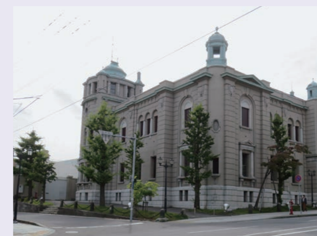
写真3 小樽市指定有形文化財の日本銀行旧小樽支店
