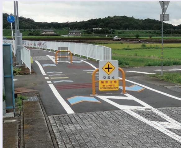
写真4 進行方向を示す矢羽根と安全対策の車止め
