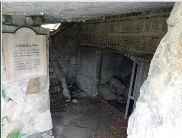
写真5 レンガ積みアーチ構造技術を応用した半地下式のワインセラー（封鎖中）
