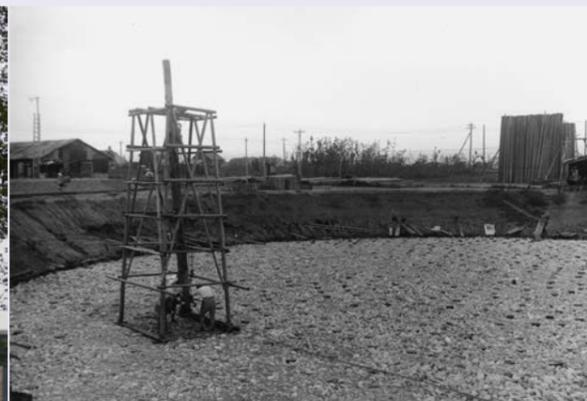
写真2 配水塔の基礎工事。おそらく木杭を打設している
