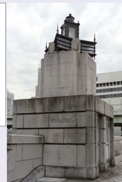
写真3 台座の中に操作室を設けた装飾灯
