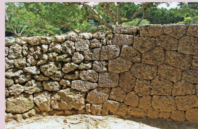
写真2 野面積みと相方積みの擁壁
