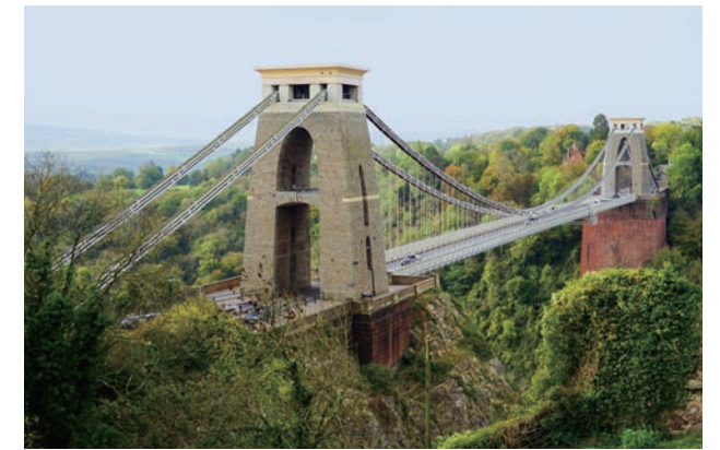
写真2 近代英国を代表するシビルエンジニアの一人ブルネルが設計したクリフтон吊橋(1864年完成)
