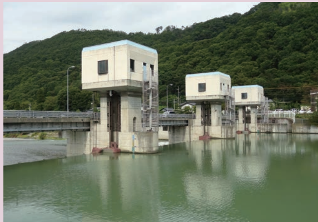
写真3 奈良井川頭首工
