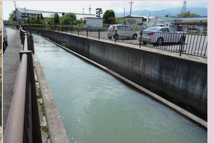
写真2 中壁で仕切られた排水機能がある区間
