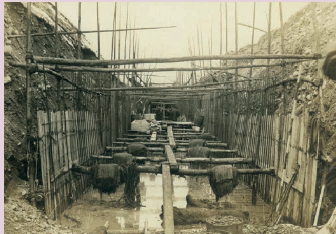
写真1 大正時代のサイフォン工事
