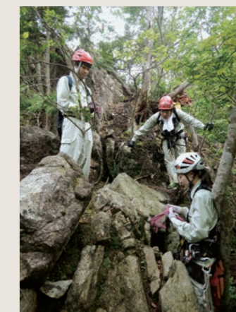
ロープアクセスによる斜面点検研修
