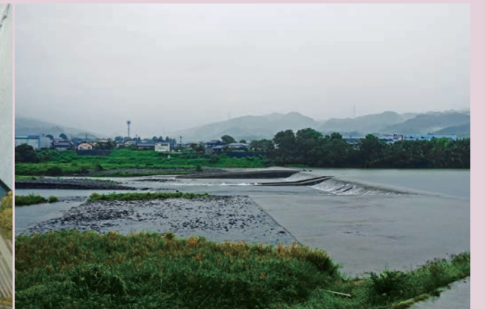
写真2 水害後コンクリートに作り変えられた大石堰
