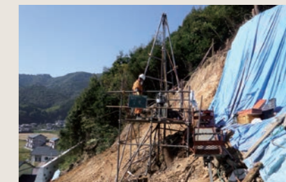
斜面崩壊箇所でのボーリング調査
