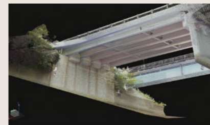
橋梁調査における3次元計測
