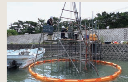
海上ボーリング調査
