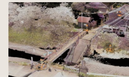
水害による落橋現場での3次元計測
