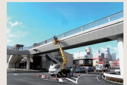
道路施設点検及び補修設計
