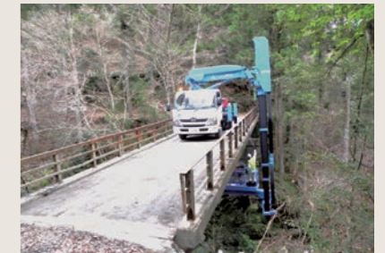
橋梁点検及び長寿命化計画策定
