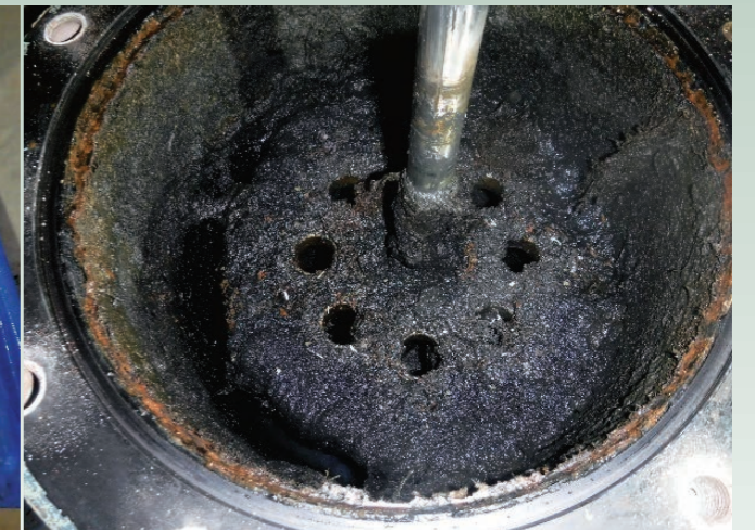
写真7 逆洗ポンプの内部写真（砂の堆積確認）
