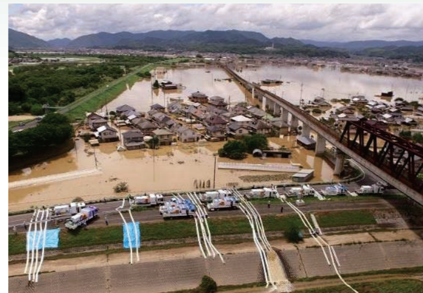
写真3 真備町地区の排水状況 (出典:国土交通省 水管理・国土保全局資料)
