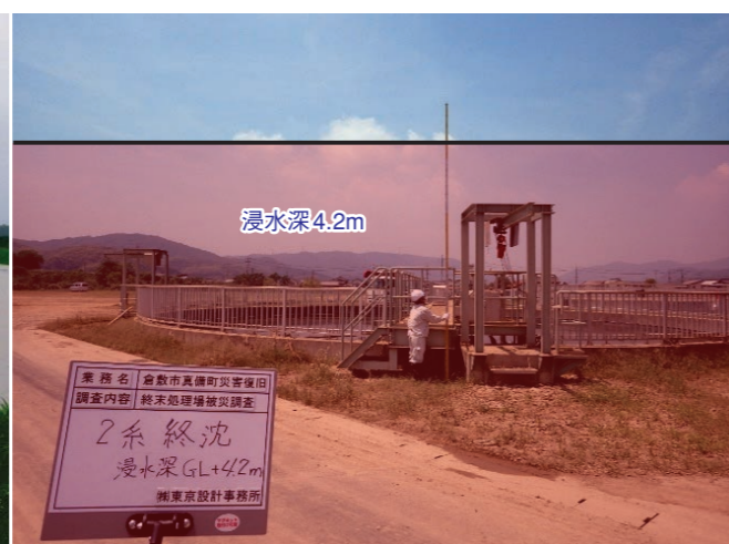
写真2 センター内施設の浸水深さ
