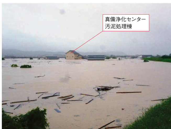
写真1 真備浄化センター全体浸水状況
