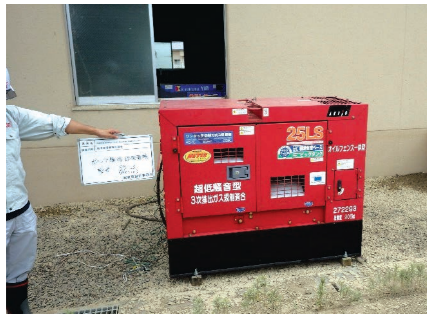
写真5 可搬式発電機
