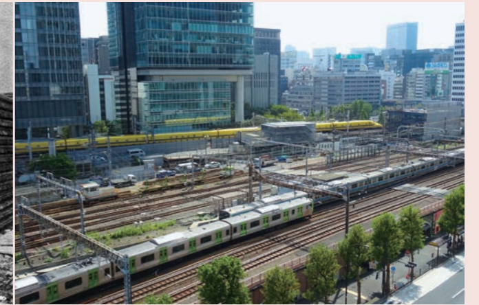
写真5 高層ビル群の中でも交通機関を支える高架橋
