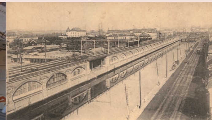
写真2 竣工当時の高架橋(銀座から内幸町を望む)
