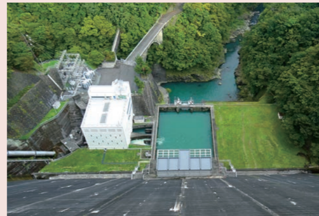
写真4 第一号取水施設と多摩川第一発電所
