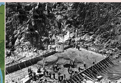
写真1 建設時のコンクリートの打込み
