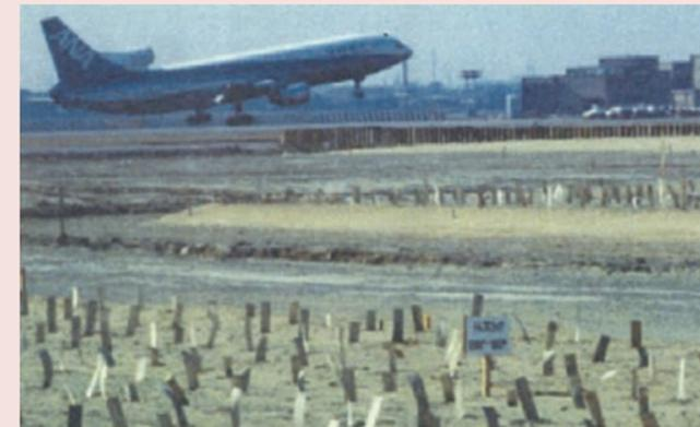
写真3 超軟弱地盤の改良（ペーパードレーン工法）
