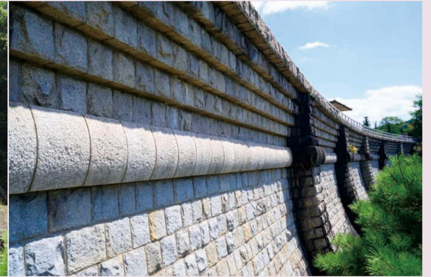
写真7 堰堤頂部の前出し
