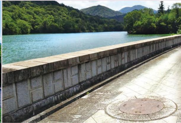
写真2 天端の壁高欄
