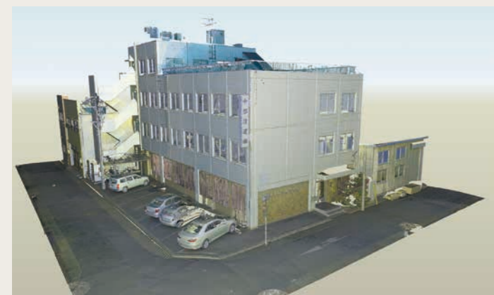
レーザスキャナ計測による社屋
