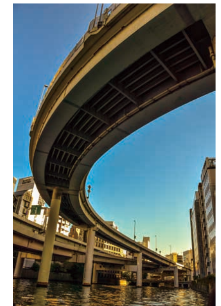
「日本橋川から見た箱崎インター」 千葉県 山田 真緒 共立女子高等学校 (撮影地：東京都中央区)
