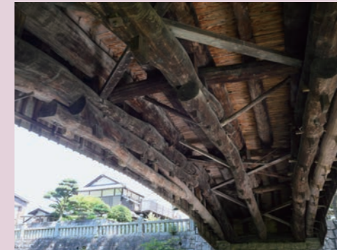
写真4 鞘橋の桁構造
