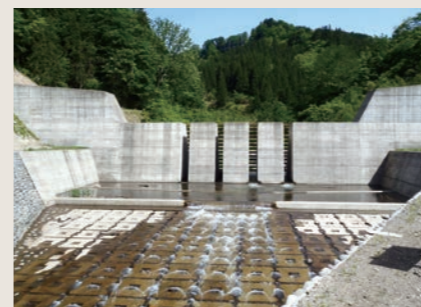
砂防堰堤 (大門川)
