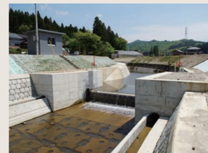
取水堰 (鹿熊川)
