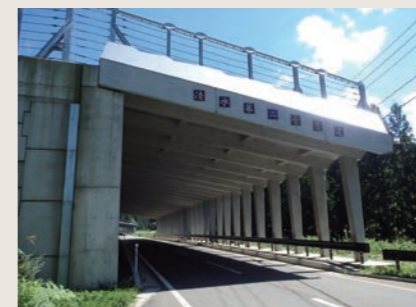
スノーシェッド (国道291号)
