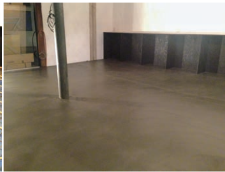
写真5 店舗床のコンクリート
