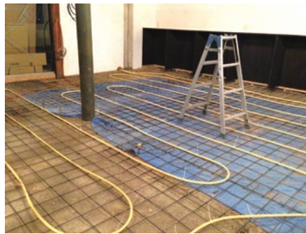
写真4 店舗床の配筋と暖房のパイプ
