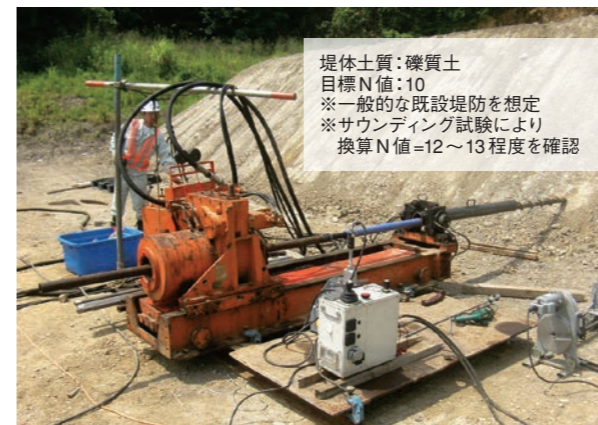
図3 水平ボーリングマシンを用いた貫入実験
