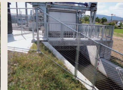
ゲートポンプ (浸水対策施設)
