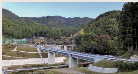
景観に配慮した道路・橋梁・法枠 (中村向河内線 みやこ町)
