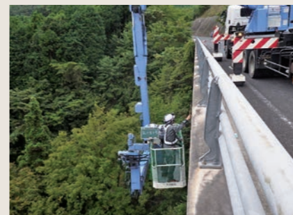
橋梁点検業務
