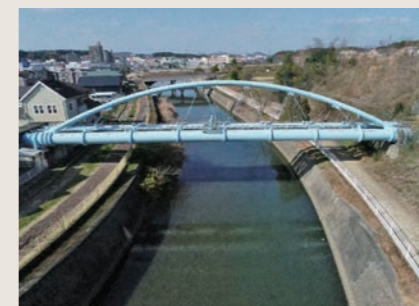
金山川を跨ぐ水管橋
