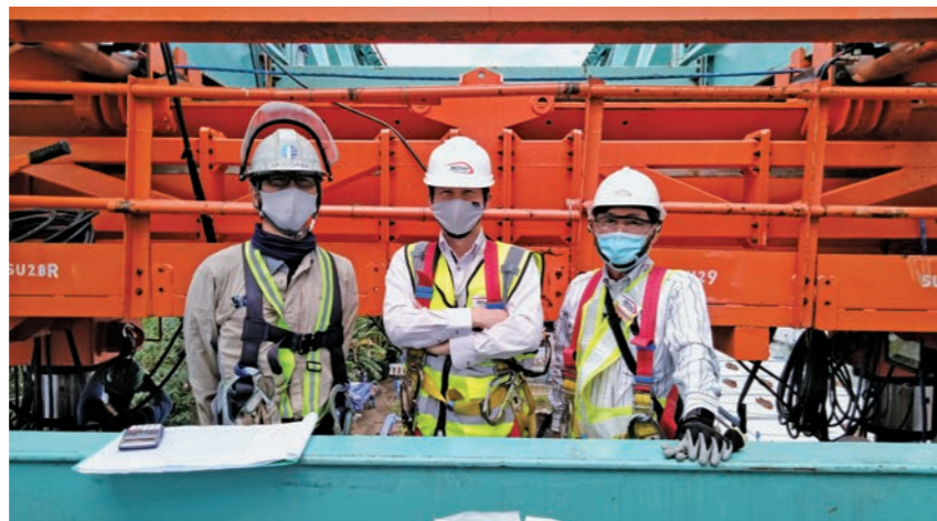
写真1 感染対策を行っている工事現場
