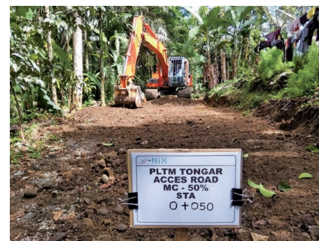
工事用道路の整地状況
