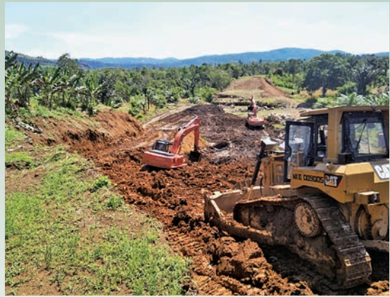
導水路区画の整地状況
