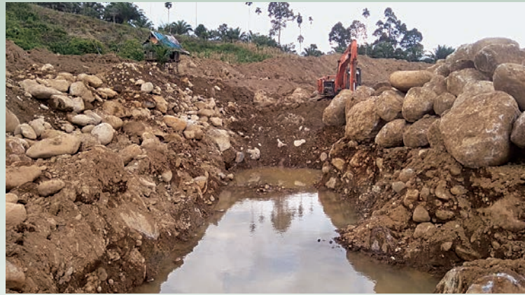
取水口部の河川切替施工状況
