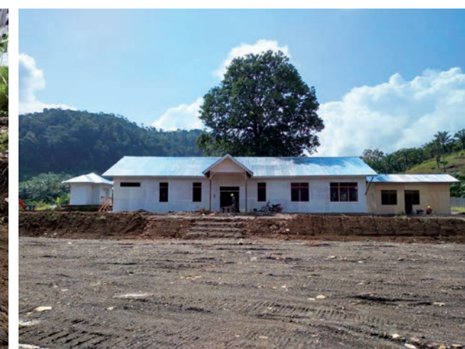
施工会社の現地寄宿舎
