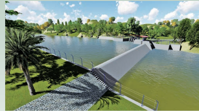
取水堰と取水口のイメージ図
