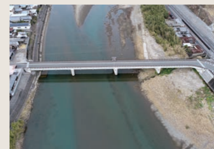
安田町 安田川橋
