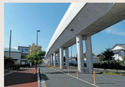
JR土讃線高架側道
